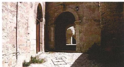
NEL CUORE DEI SASSI Il Palazzo nobiliare che fu del casato dei De Noha è costituito da una serie di sovrapposizioni architettoniche dal XV al XVII secolo
